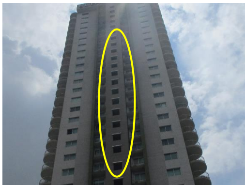
ช่องระบายอากาศประจำชั้น และกระจกสีเขียวตัดแสงของห้องพัก
